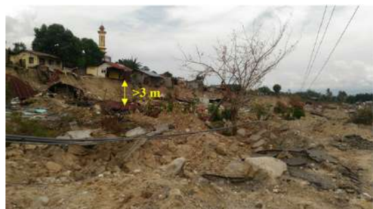
Gambar 1.2. Jalan amblas > 3 m pada mahkota longsor akibat likuefaksi di daerah balaroa.
