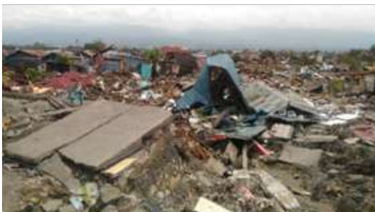
Gambar 1.5. Kerusakan yang ditimbulkan oleh fenomena likuefaksi bertipe aliran.
