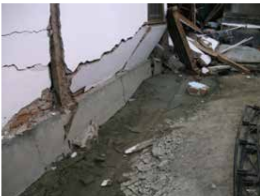
Gambar 3.13. Gambar kiri: Likuefaksi mengakibatkan kerusakan rumah penduduk akibat gempa bumi tanggal 28 September 2018 di Desa Panau, Kecamatan Sigi Biromaru, Kabupaten Sigi. Gambar kanan: gerakan tanah tipe nendatan dan aliran mengancam penduduk Desa Sungku, Kecamatan Kulawi, Kabupaten Sigi.
