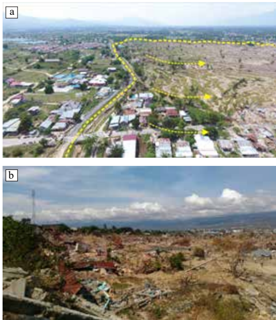
Gambar 1.1. Flow liquefaction yang terjadi di Petobo (a) dan Balaroa (b) akibat gempa Palu 2018.
