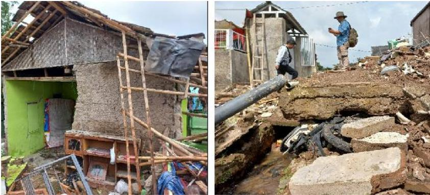
Gambar 1. Rumah penduduk rusak berat yang tergolong bangunan tidak tahan gempa bumi di Desa Cibereum (gambar kiri) dan di Desa Gasol (gambar kanan). Kedua desa tersebut terletak di Kecamatan Cugenang.
