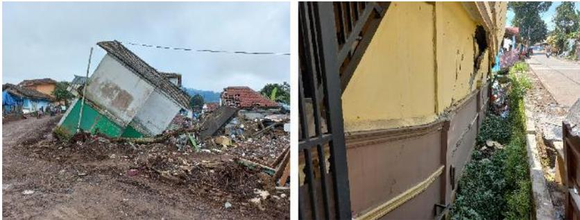
*Gambar 6. Kerusakan rumah penduduk dikontrol oleh bahaya ikutan gerakan tanah di desa Sarampad (Gambar kiri) dan proses likuefaksi di Desa Benjot (Gambar kanan). Kedua desa tersebut terletak di Kecamatan Cugenang.*
