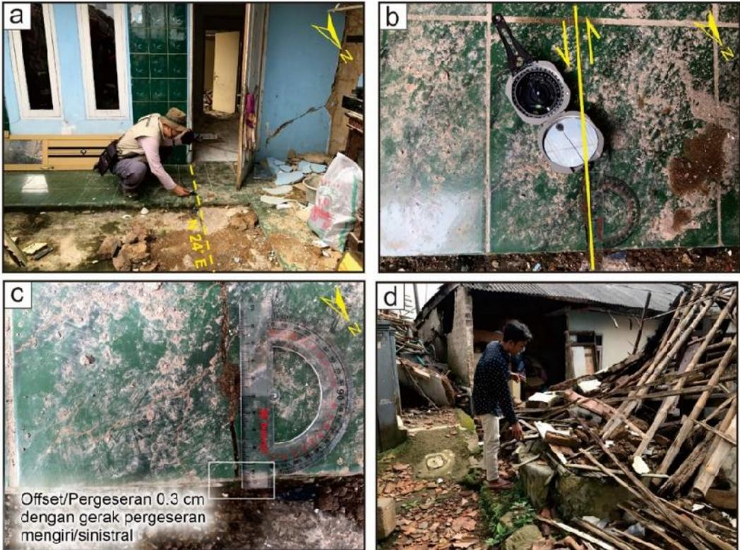
Gambar 23. Retakan permukaan yang memotong rumah penduduk di Kampung Longkewang, Desa Benjot. Secara umum arah retakan ini relatif Utara – Selatan (N240E). (a) dan (b) retakan minor yang memperlihatkan arah pergeseran mengiri (sinistral) dengan pergeseran lateral sebesar 0.3 cm. (d) sumur penduduk yang mengalami penyusutan air.
