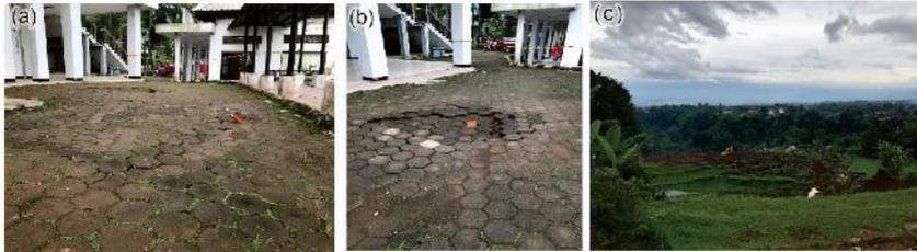
Gambar 13. (a) merupakan retakan permukaan di sekitar Masjid Alfirdaus, retakan ini nerarah relatif utara-barat laut – selatan-tenggara (NNW-SSE), sedangkan (b) merupakan longsoran sebagai bahaya ikutan akibat gempa dengan arah longsor ke arah tenggara (lihat gambar 11/Google Earth).
