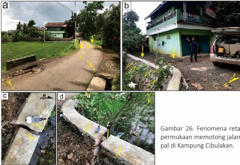
Gambar 26. Fenomena retakan permukaan memotong jalan aspal di Kampung Cibulakan.
