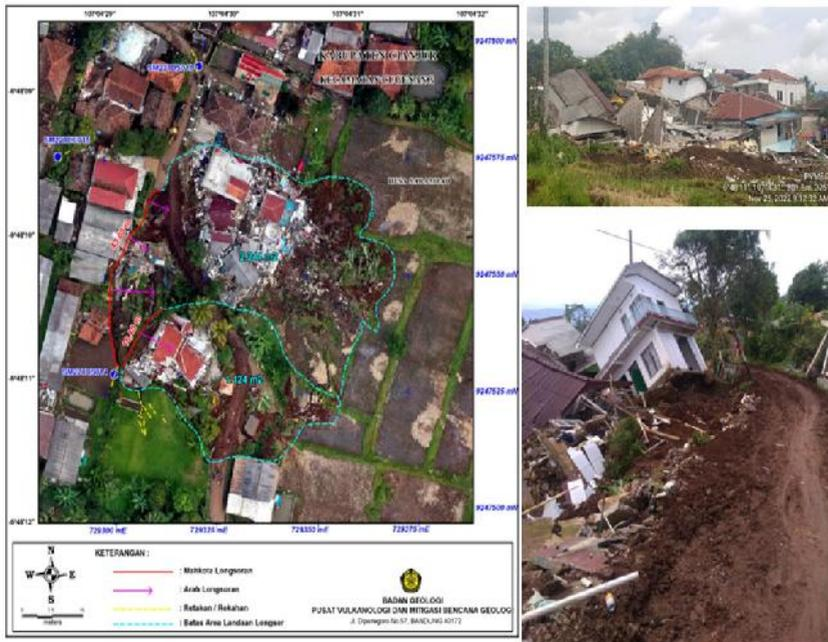
Gambar 7. Gerakan tanah tipe pencaran lateral dan kerusakan bangunan Di Kp. Cisarua, Sarampad
