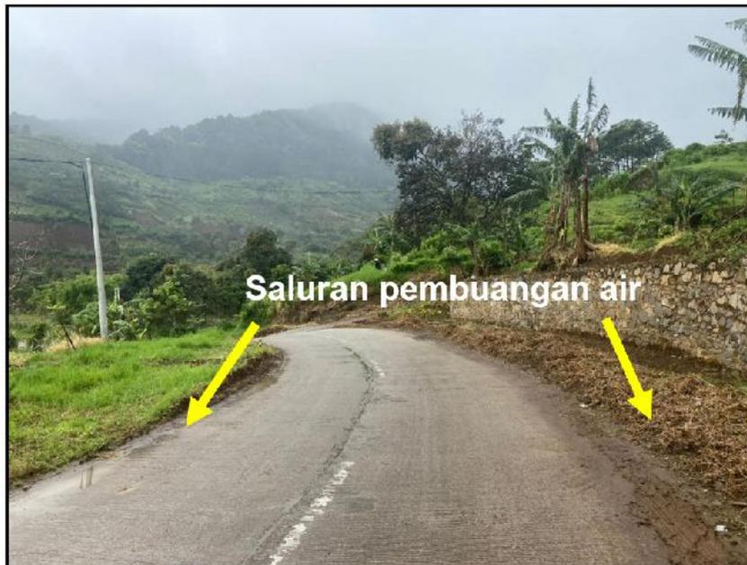
*Gambar 31. Jalan puncak 2 (lereng bagian atas area calon lahan relokasi) tidak terdapat saluran pembuangan perlu dibuatkan saluran air pada kedua sisi jalan agar tidak menjenuhi daerah calon lahan relokasi yang berada pada lereng bagian bawah jalan;*
