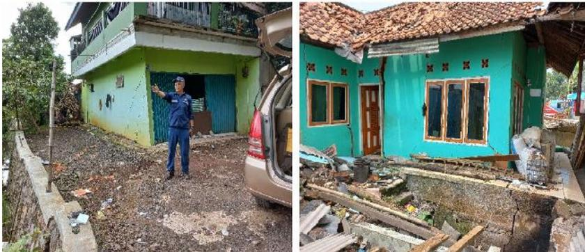
*Gambar 3. Retakan tanah mengontrol kerusakan bangunan di Desa Cibulakan (gambar kiri) dan di Desa Rawa Cina (gambar kanan). Kedua desa tersebut terletak di Kecamatan Cugenang.*
