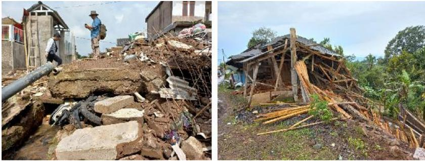
*Gambar 3. Bangunan lantai dua yang tidak dirancang tahan gempa bumi menjadi roboh di Kampung Longkewang, Desa Gasol, Kecamatan Cugenang (Gambar kanan). Kerusakan bangunan terletak pada tepi lereng di Desa Benjot, Kecamatan Cugenang (Gambar kiri).*
