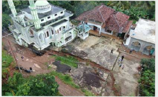
Dampak gerakan tanah menyebabkan masjid rusak di Kecamatan Simpenan, Kabupaten Sukabumi
