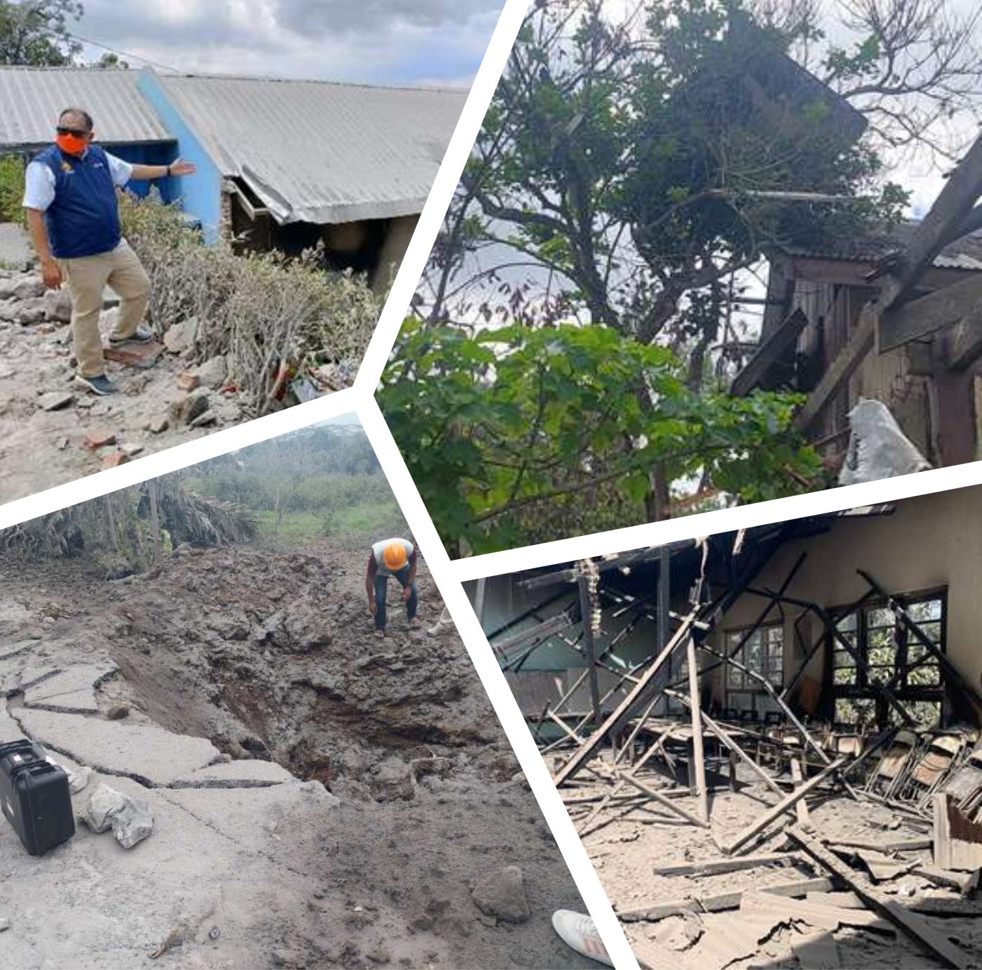
Beberapa dampak kerusakan lahan dan bangunan akibat lontaran batuan pijar (balistik) erupsi Gunung Lewotobi Laki-laki, Nusa Tenggara Timur, 3 November 2024.
