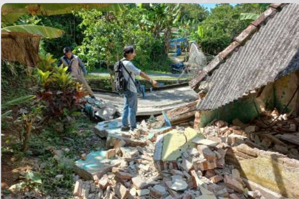
Kerusakan rumah penduduk akibat gempa bumi Pulau Bawean 22 Maret 2024 ( M 6,5 ) karena konstruksi bangunan di Desa Dekatgunung, Sangkapura.
