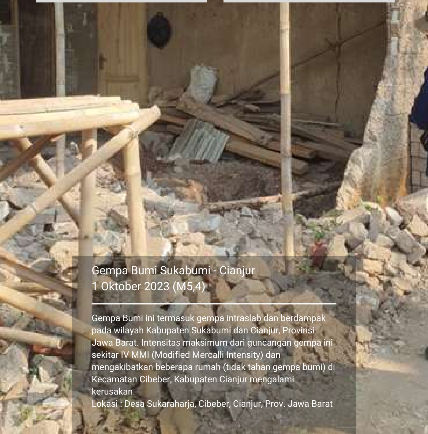
Retakan dinding rumah di Kampung Pasir Munding akibat gempa bumi
