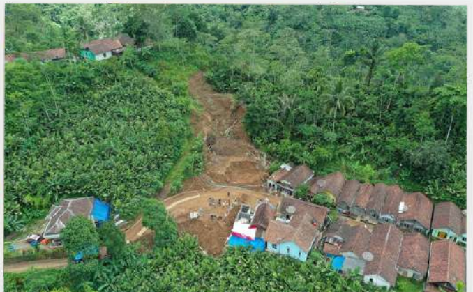
Pemeriksaan kejadian gerakan tanah di Desa Tlaga, Kecamatan Punggelan, Kabupaten Banyumas, Provinsi Jawa Tengah, Januari 2024
