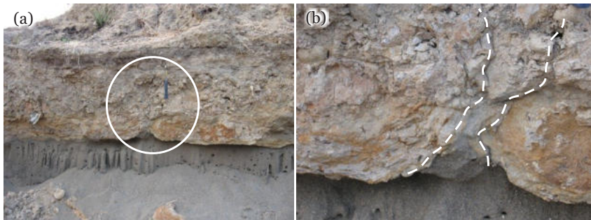
Gambar 6.24. (a) Salah satu retakan akibat gempa purba ( rupture ) pada satuan endapan pantai, (b) perbesaran dari (a) rupture ditunjukkan dengan garis merah putus-putus (Foto : Sukahar Eka A. Saputra, 2007).
