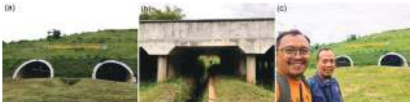
Gambar 6.10 Pengecekan salah satu fasilitas vital nasional – terowongan “twin tunnel” Cisumdawu. Tidak ada kerusakan berarti di bagian inlet terowongan dan juga tiang penyangga jalan tol.
