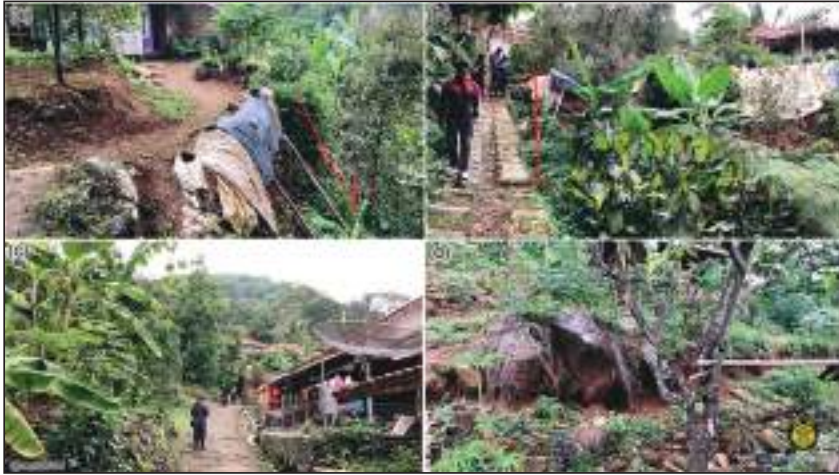
Gambar 5.29 Gerakan tanah di Kampung Ciempleng, Desa Cinangsi, Kecamatan Cisitu, Kabupaten Sumedang. Gerakan tanah signifikan terjadi semenjak tahun 2010 yang menyebabkan turunnya permukaan tanah/gawir seperti terlihat pada Gambar (a) dan (b), permukaan tanah telah mengalami penurunan kurang lebih 1,5 meter (b) semenjak tahun 2006. Tanda panah merah menunjukkan arah penurunan (a). (c) Morfologi area gerakan tanah berupa perbukitan berlereng terjal, (d) batuan alas area gerakan tanah tersusun atas breksi yang terdiri dari bongkah – bongkah batuan beku andesit. Foto: Sukahar Eka, 2024.
