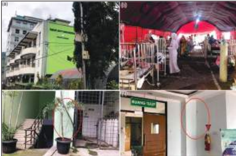
Gambar 6.9 Pengecekan salah satu fasilitas penting Rumah Sakit Umum Daerah (RSUD) Kabupaten Sumedang yang berlokasi di pusat Kota Sumedang. Kerusakan di RSUD tersebut cukup ringan – sedang hanya jatuhnya plesteran dan retakan di sambungan tiang dengan dinding (c) dan (d). Namun, guncangan gempa membuat pasien panik, sehingga terpaksa membuat bangsal rumah sakit di bawah tenda (b).
