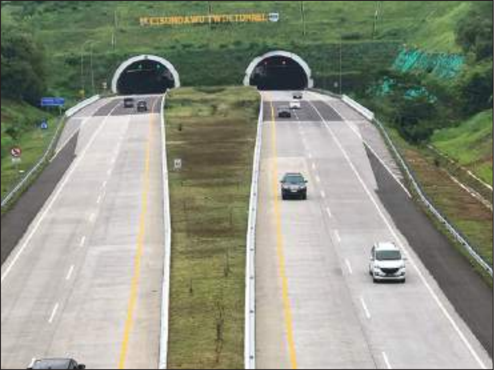
Gambar 1.9 Jalan Tol dan Terowongan Twin Tunnel Cisumdawu. Menjadi terowongan jalan tol pertama di Indonesia dan Tol Cisumdawu menjadi akses jalan tol penghubung kota Sumedang dengan Ibukota Provinsi Jawa barat, Bandung. Foto: Sukahar Eka, 2024.
