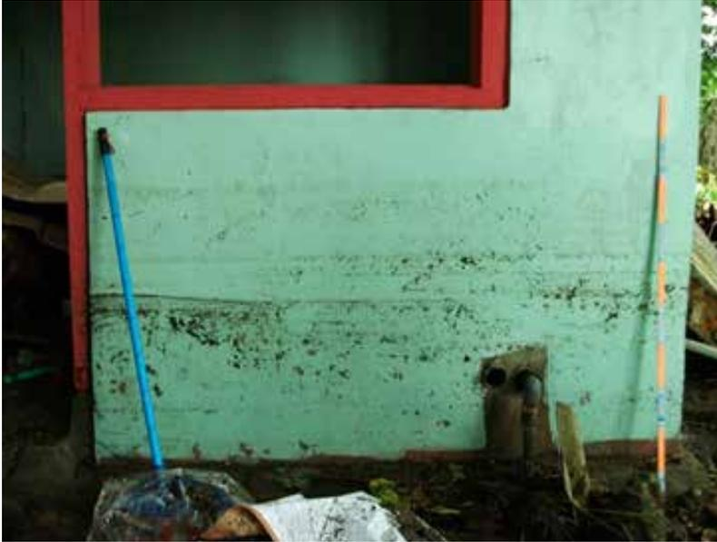
Gambar 12.9. Jejak tinggi rendaman tsunami pada dinding bangunan (water mark). FD di lokasi ini 80 cm di Kampung Cibenda, Kecamatan Carita, Kabupaten Pandeglang.
