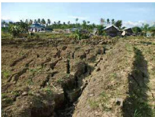
Gambar 3.15. Retakan tanah masif berarah utara – selatan mengakibatkan kerusakan rumah penduduk di daerah Jono Oge, Kecamatan Sigi Biromaru, Kabupaten Sigi akibat gempa bumi 28 September 2018.
