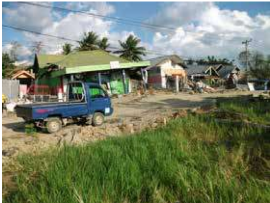
Gambar 3.14. Tanah bergelombang yang mengakibatkan kerusakan bangunan di daerah Jono Oge, Kecamatan Sigi Biromaru, Kabupaten Sigi akibat gempa bumi 28 September 2018. Skala intensitas gempa bumi di daerah Jono Oge mencapai IX MMI.
