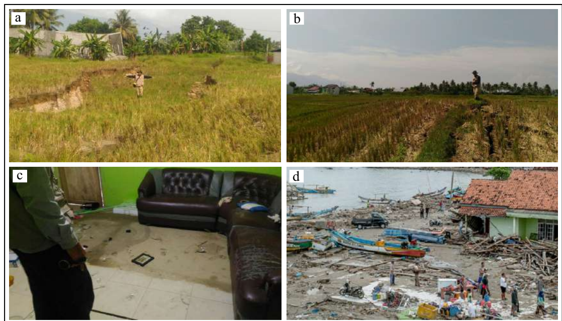
Gambar 4.3.1. Contoh kerusakan tanah permukaan tiap kelas dan kerusakan akibat tsunami. a) kerusakan tanah permukaan tinggi; b) kerusakan tanah permukaan sedang; c) kerusakan tanah permukaan rendah; d) kerusakan tanah karena tsunami (Sumber: Buana dan Supartoyo)
