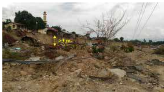
Gambar 1.2. Jalan amblas > 3 m pada mahkota longsor akibat likuefaksi di daerah balaroa.
